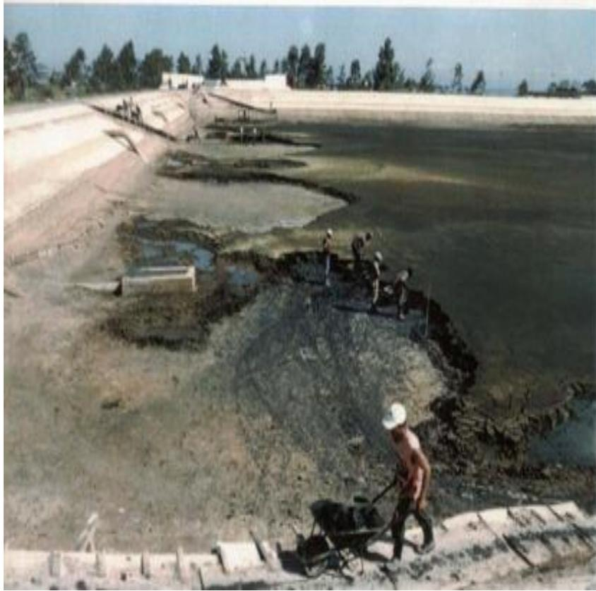
**Fonte: LODO – Remoção manual do lodo de lagoa anaeróbia – Vitoria (ES)
