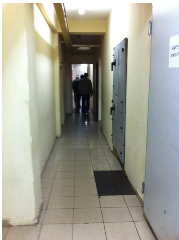
Figura 30 – Regularização de piso rampado no pavimento Térreo, circulação 01.
