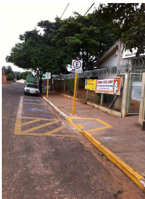
Figura 13 – Adequar demarcação de vaga especial. Fonte: Secretaria do Planejamento de Bauru
