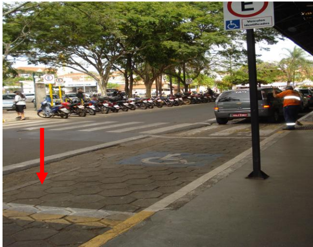
Figura 20 – Vaga especial e rampa ligada a calçada p/ P.c.D existente.
