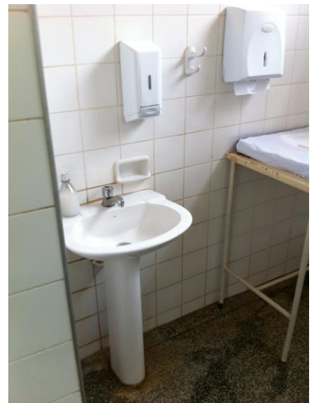
Figura 19 – Adequar Sanitários Públicos com instalação de lavatórios suspensos, barras de apoio, botoeira de emergência, portas com aberturas invertidas e barras na face interna. Fonte: Secretaria do Planejamento de Bauru
