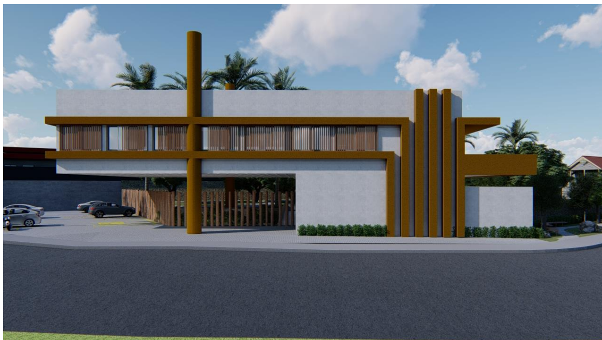
Figura 23. Fachada Fonte: Autor
