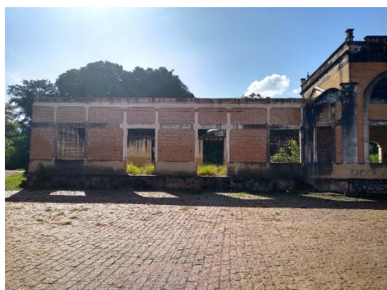
Figura 9. Fachada do anexo esquerdo da estação ferroviária (acervo pessoal).
