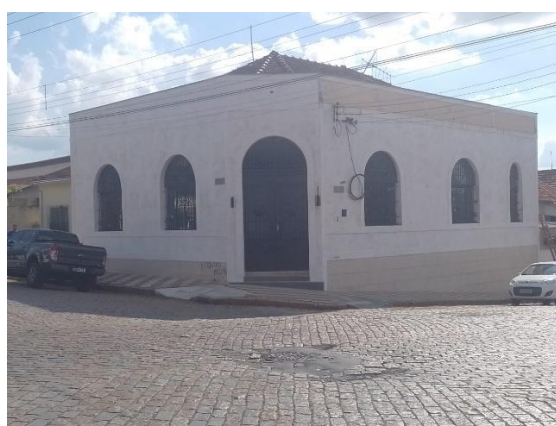
Figura 5. Fachada do antigo edifício do Banco Noroeste em Pirajuí-SP (acervo pessoal).
