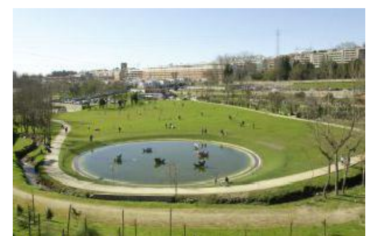
Bacia de contenção em parque (Fonte: GSD Engenharia)
