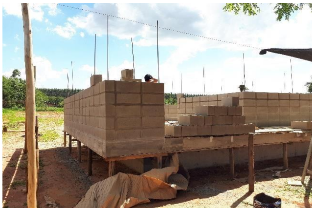
Figura 1. Uso de bloco de concreto como paredes autoportantes (produção do autor)
