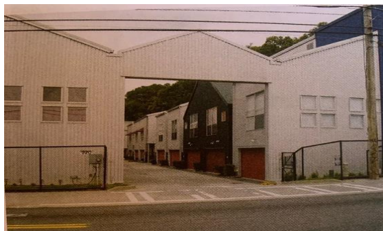
Figura 3. Revestimento metálico aplicado (cengarge learning ,2013)
