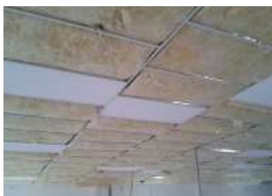
Figura 24. Lã de vidro, isolamento térmico – Fonte: Engenharia Química - UNISUL
