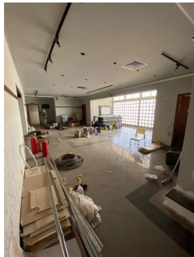
Figura 7. Hall foyer sem manutenção. (Acervo pessoal 2023)
