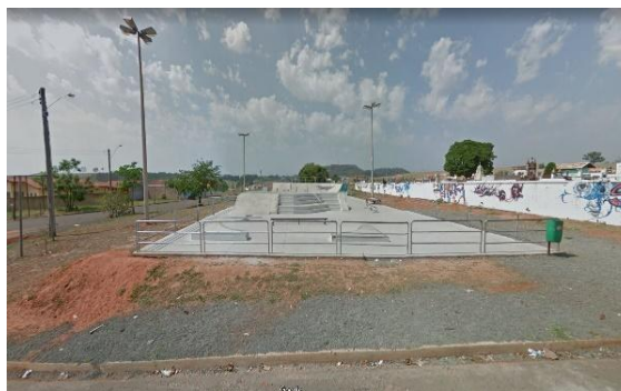
Figura 4. Praça em 2012 – Momento da construção. Fachada Rua Santa Cruz dos Inocentes. Fonte: Google Maps
