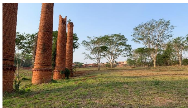
Figura 3. Imagens atuais do terreno.
