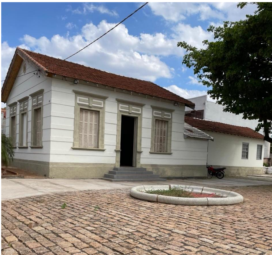
Figura 1. Imagem do edifício atualmente
