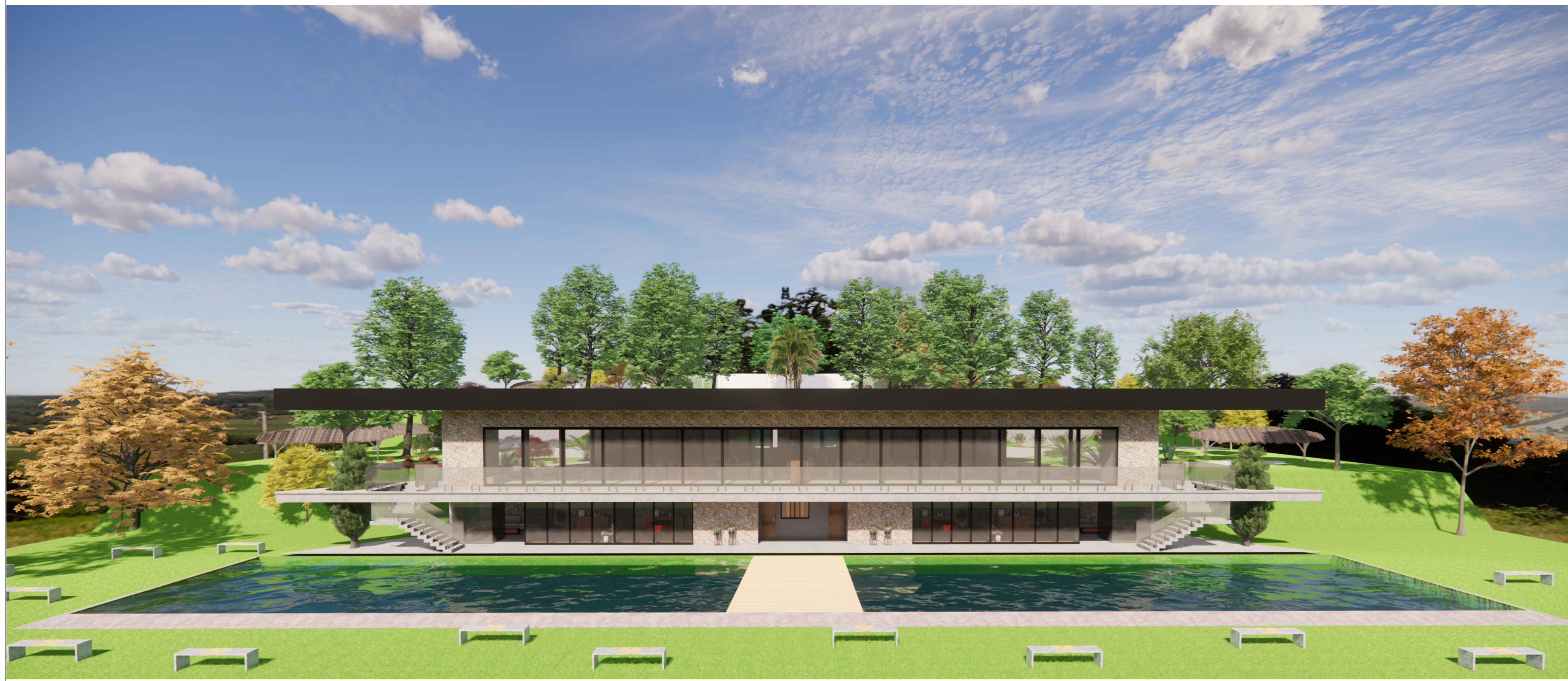
- VISTA FACHADA SUBSOLO -
