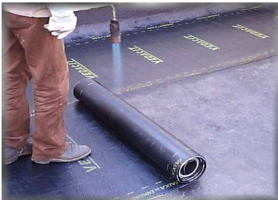
Figura 9 - Impermeabilização com manta asfáltica
