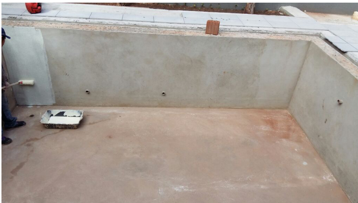
Figura 15 – Aplicação do poliuretano vegetal
