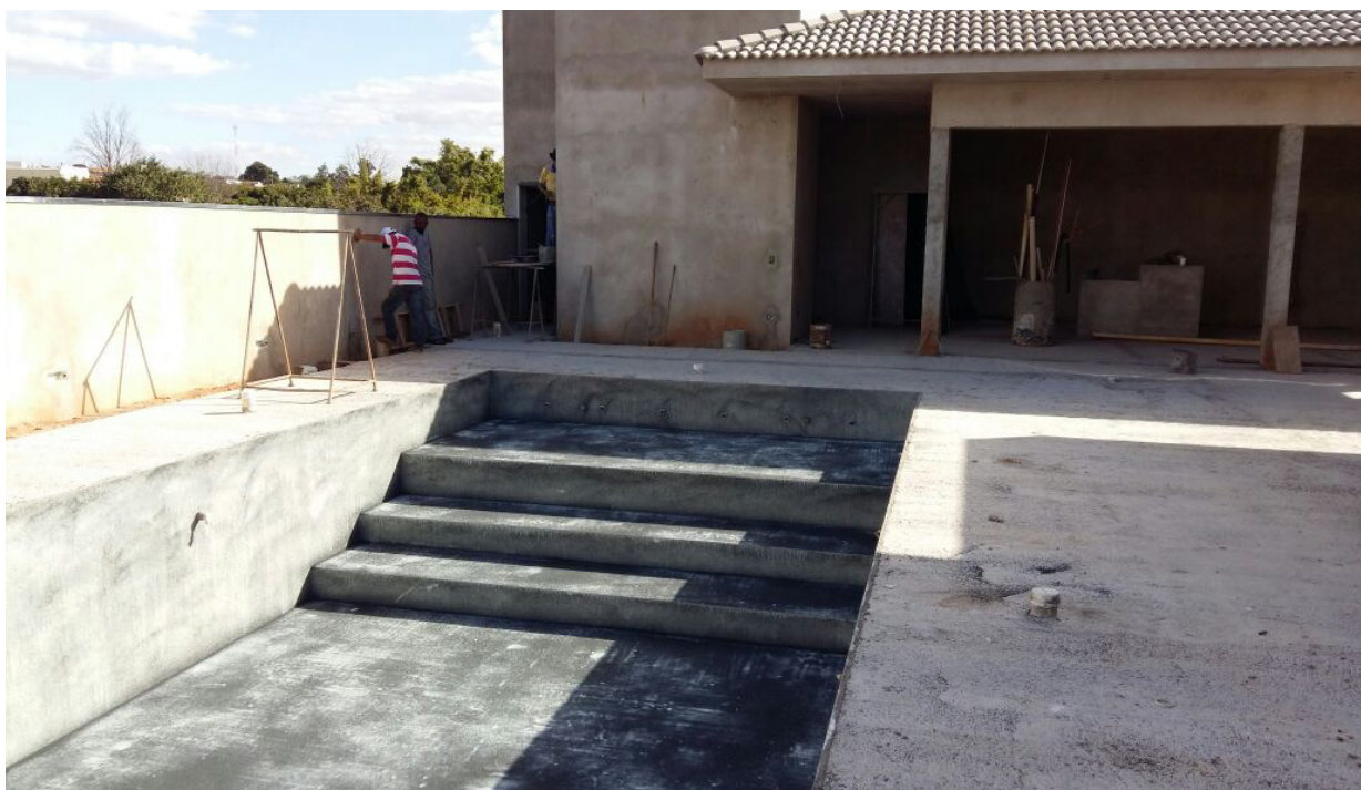
Figura 14 - Impermeabilização com poliuretano vegetal 02
