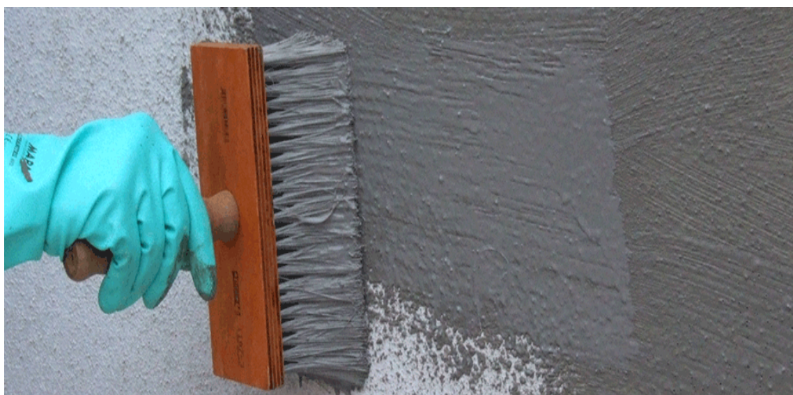
Figura 10 - Impermeabilização com argamassa polimérica
