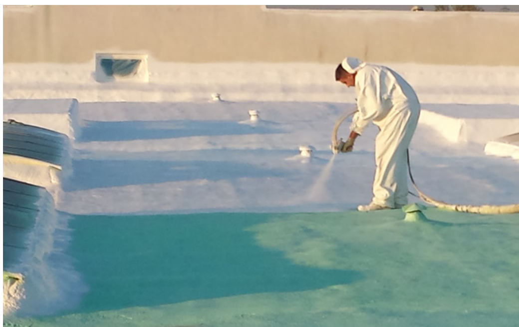
Figura 11- Impermeabilização com membrana acrílica
