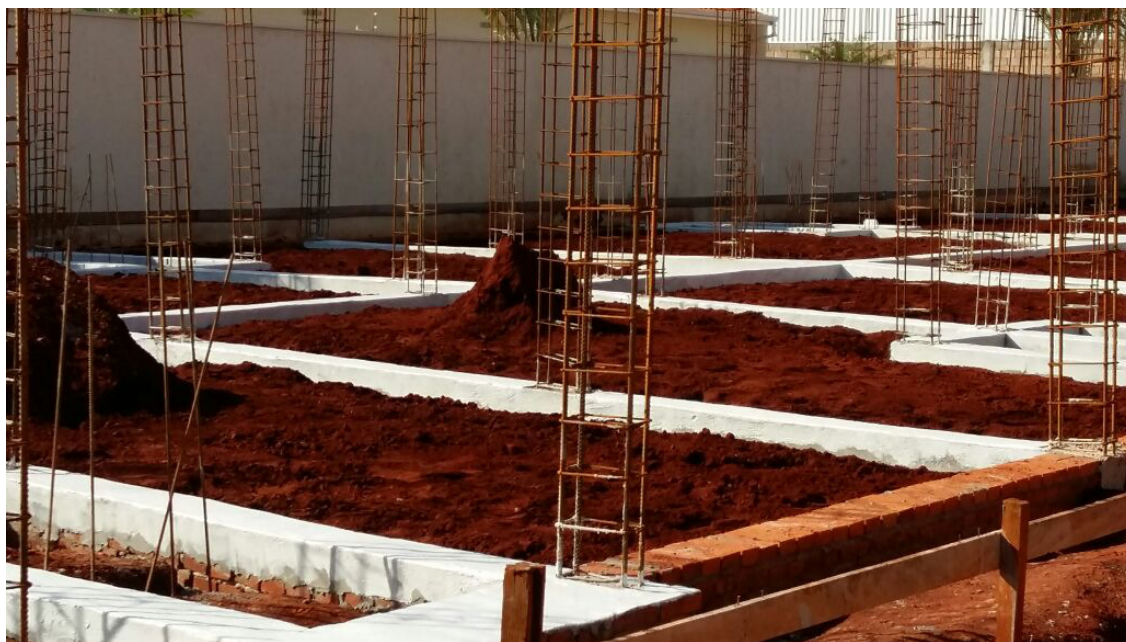
Figura 16 – Impermeabilização com poliuretano vegetal 03
