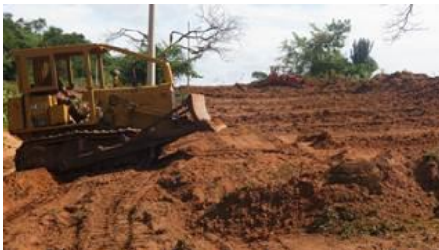
Figura 15 – Terraplanagem e estruturação da PTG 337 parceria com a CODASP
