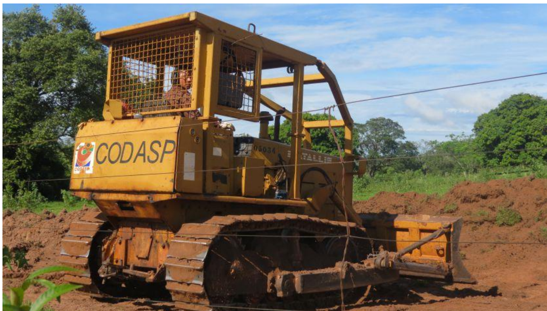
Figura 14 – Início das obras de estruturação da PTG 337 parceria com a CODASP
