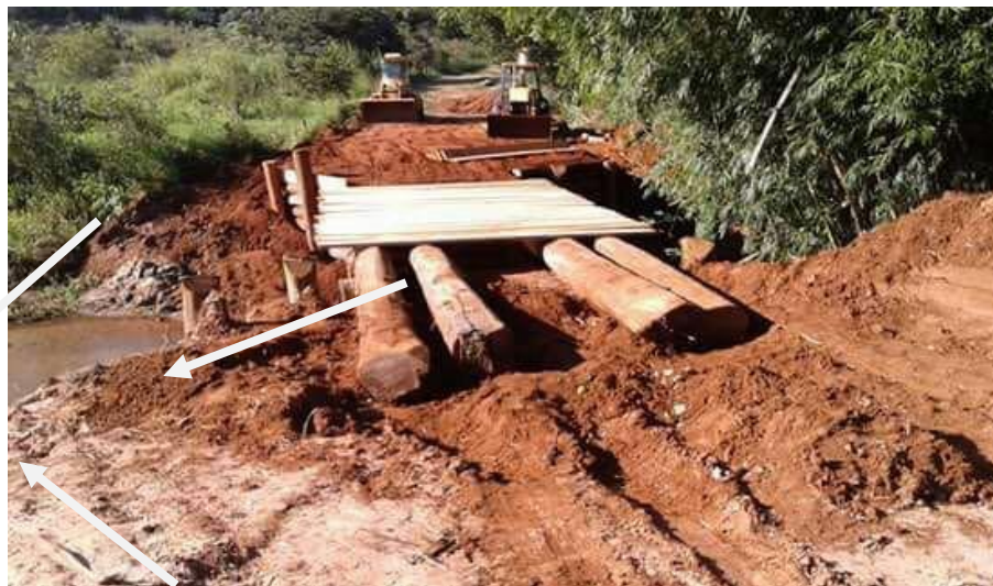
Figura 06 – PTG 338 / estrada com erosão
