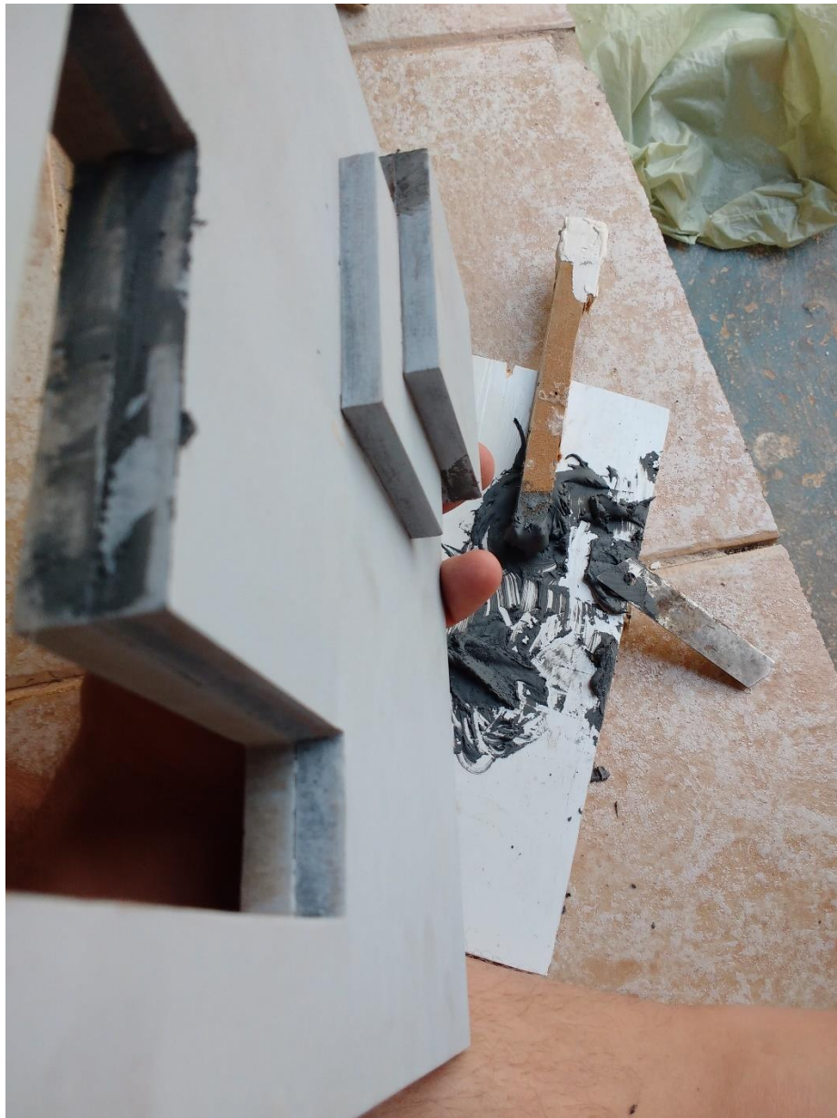
Figura 74: Aplicação de massa rápida.
