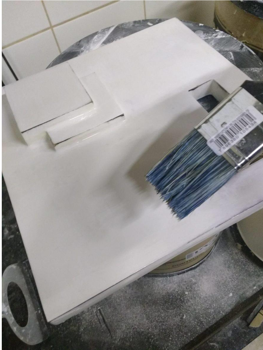
Figura 56: Aplicação da resina acrílica a base de água.
