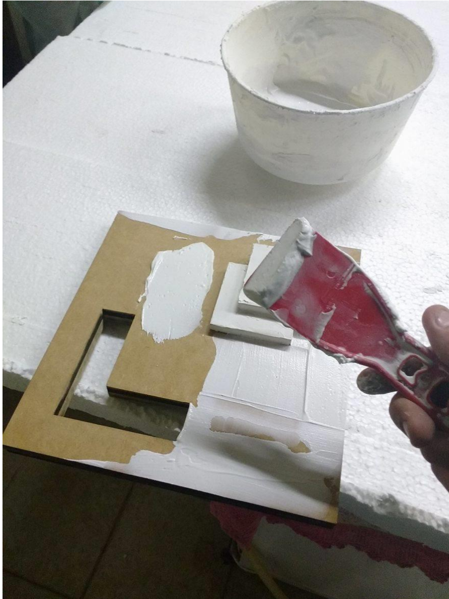
Figura 53: Massa sendo aplicada na superfície do protótipo.
