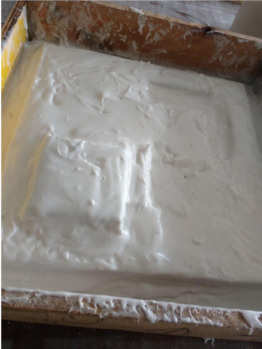
Figura 85: Finalização da aplicação do silicone.
