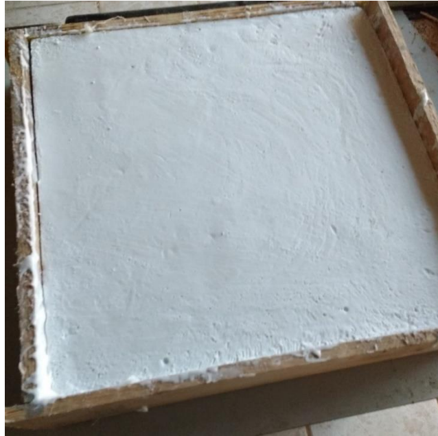
Figura 88: Molde em processo de finalização.
