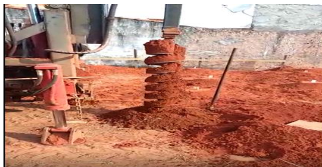
Figura 5 - Perfuração de estaca
