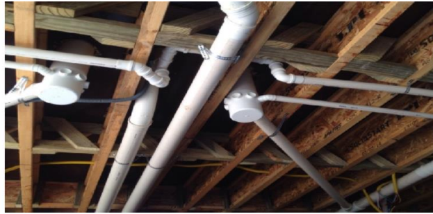
Figura 16 - Ramais de esgoto em residencia wood frame
