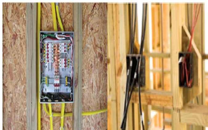
Figura 15 - Sistema elétrico para Wood Frame
