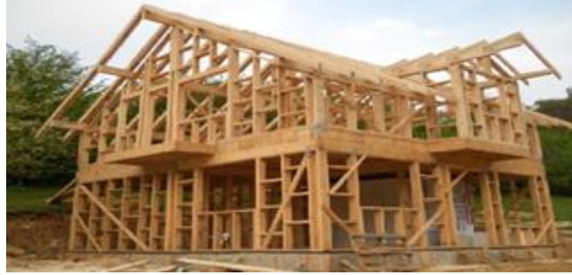
Figura 11 - Estrutura de uma casa em wood frame
