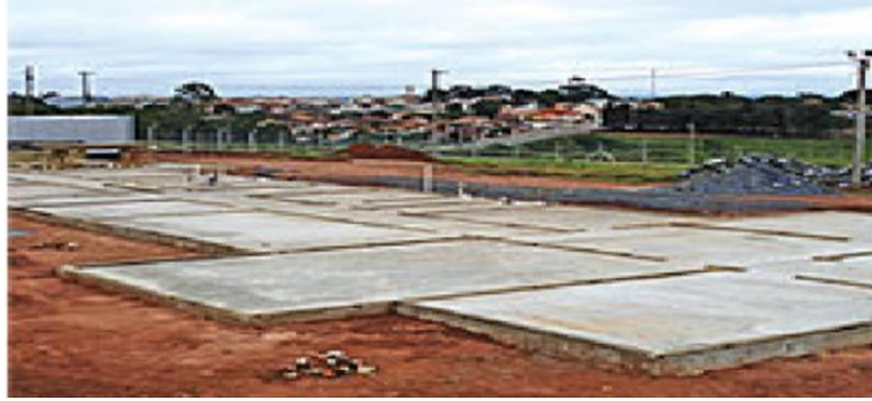
Figura 13 - Fundação tipo radier
