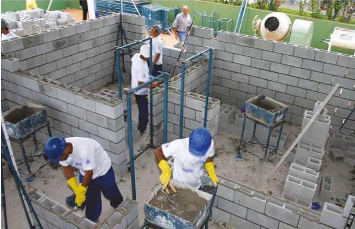
Figura 2 - Exemplo de alvenaria autoportante
