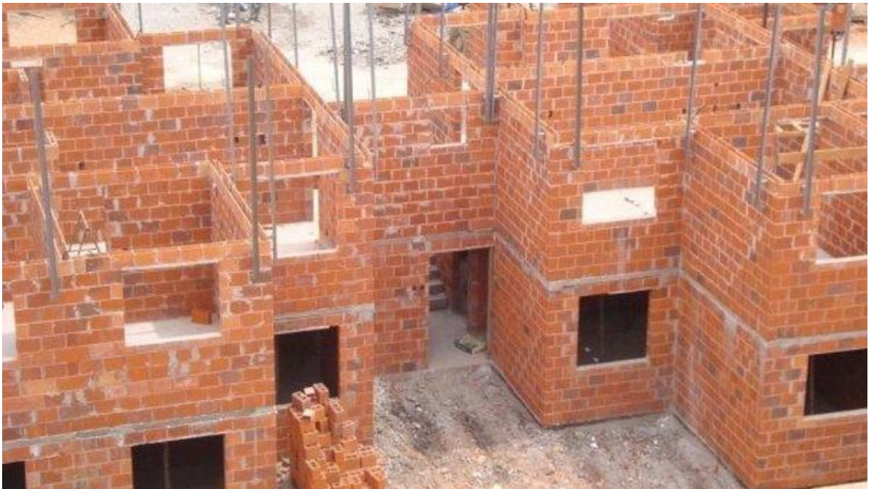
Figura 3 - Sistema de alvenaria de vedação
