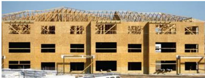
Figura 10 - Exemplo de grandes estruturas em wood frame
