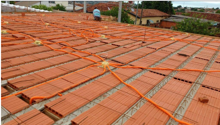
Figura 8 - Laje pré-fabricada pronta para concretagem
