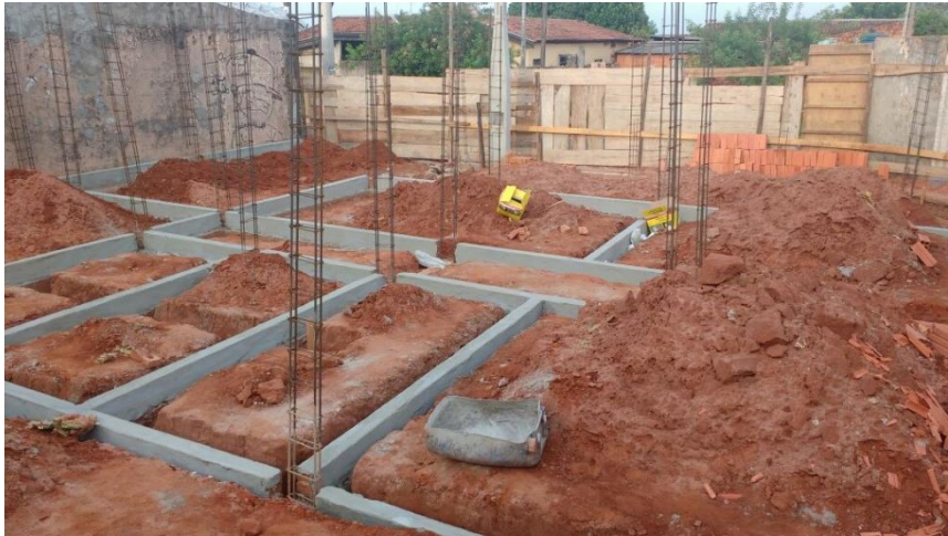
Figura 4 - Fundação viga baldrame
