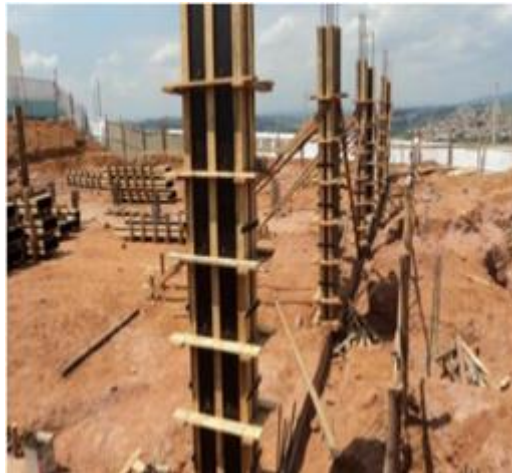
Figura 6 - Pilar de concreto pronto para concretagem
