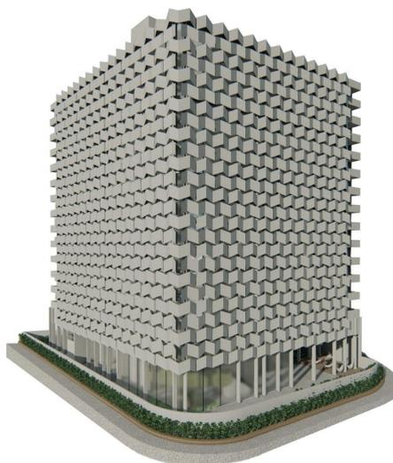
**Figura 3.** Brise na fachada do edifício (produção do autor)
