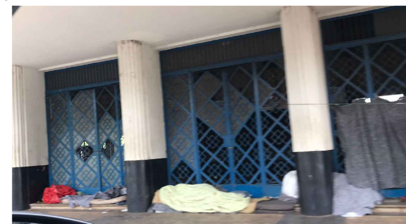
Margens da Estação Ferroviária de Bauru nos dias atuais.
